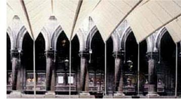
Grat- und Kehlflächen bieten sich an, um flächige Ebenen zu erzeugen, die durch Raffung sogar beweglich ausgeführt werden können. Zu Beachten ist, dass ausreichendes Gefälle für Entwässerung vorhanden ist und Schneeansammlung in den Kehlen das Tragwerk nicht zerstört. Ein Durchschlagen der Fläche bei Windsog muss durch entsprechende Vorspannung verhindert werden [Koc04, S.77].
