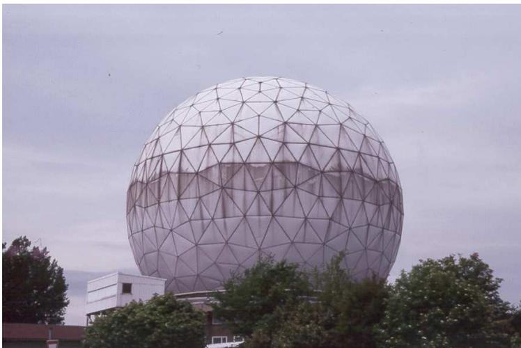
Bild 14 Netzwerkkuppel mit 49 m Durchmesser
